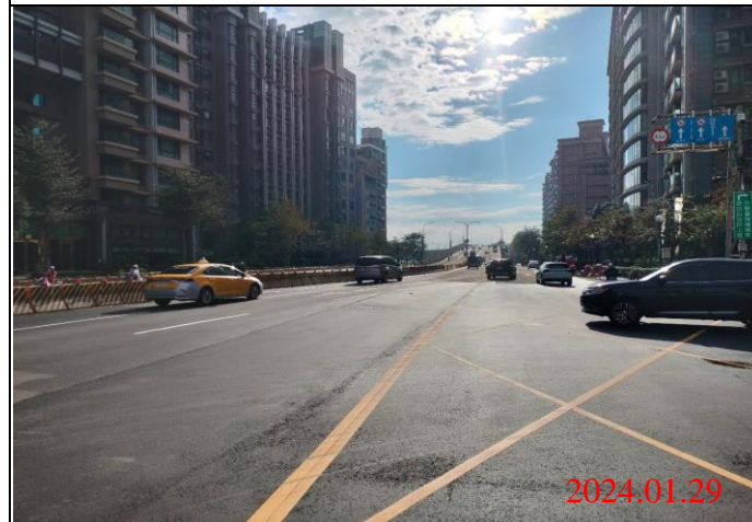
巡查日期地點：113.01.29/ Y23車站 照片說明：路面狀況
