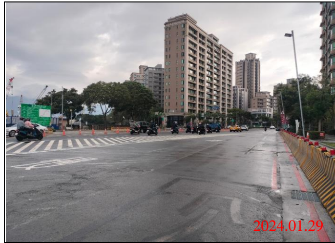
巡查日期地點：113.01.29/ Y22車站 照片說明：路面狀況
