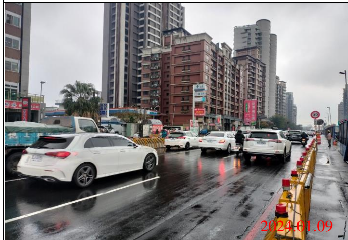
巡查日期地點：113.01.09/ Y23車站 照片說明：路面狀況
