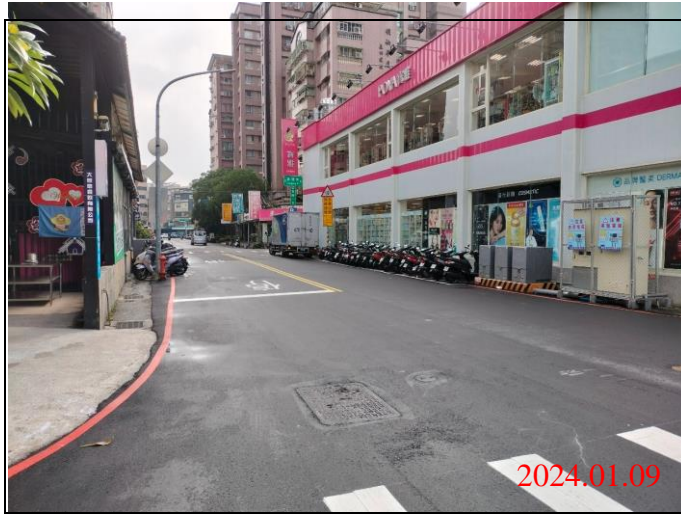
巡查日期地點：113.01.09/ Y21車站 照片說明：路面狀況
