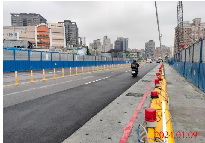
巡查日期地點：113.01.09/ Y22車站 照片說明：路面狀況
