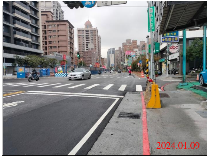
巡查日期地點：113.01.09/ Y22車站 照片說明：路面狀況
