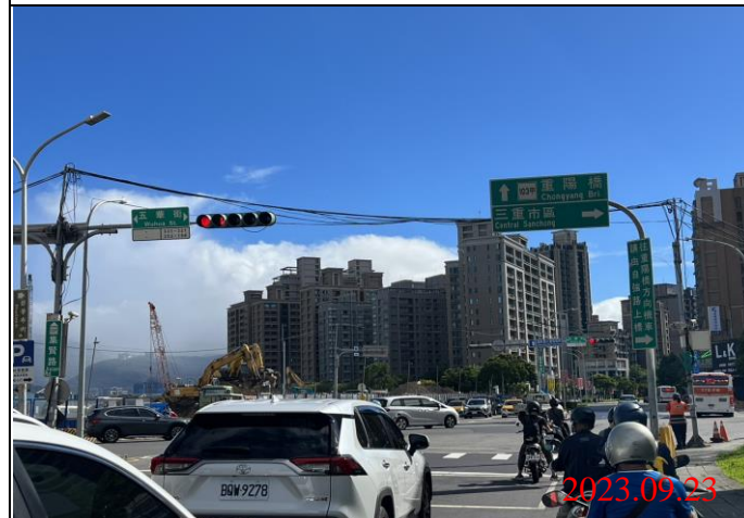
巡查日期地點：112.09.23/ Y22車站 照片說明：牌面設置狀況
