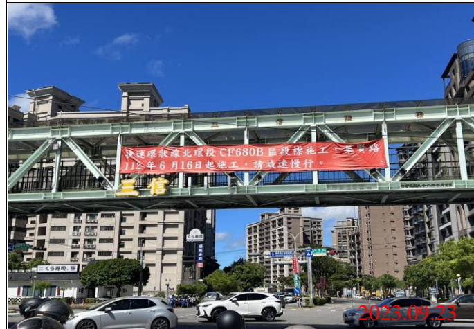
巡查日期地點：112.09.23/ Y23車站 照片說明：牌面設置狀況
