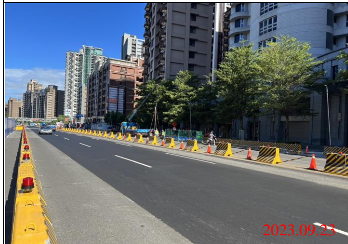
巡查日期地點：112.09.23/ Y23車站 照片說明：路面狀況
