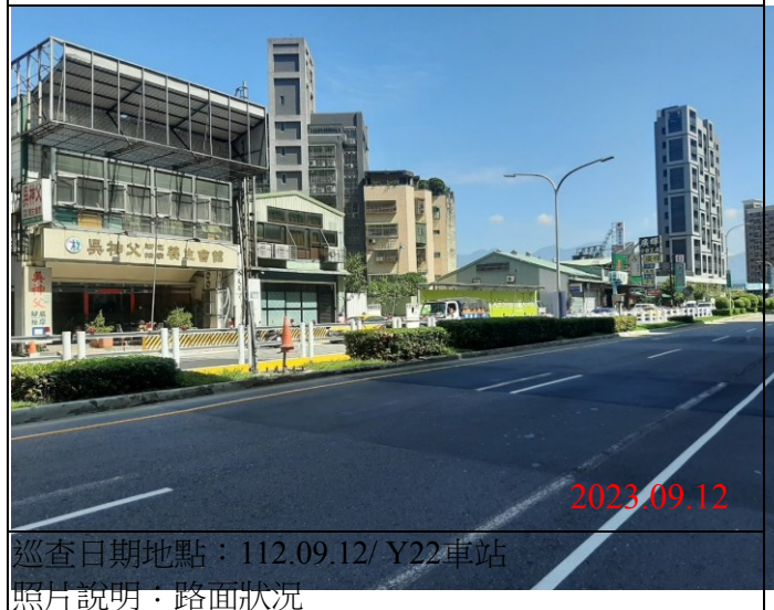
巡查日期地點：112.09.12/ Y22車站 照片說明：路面狀況
